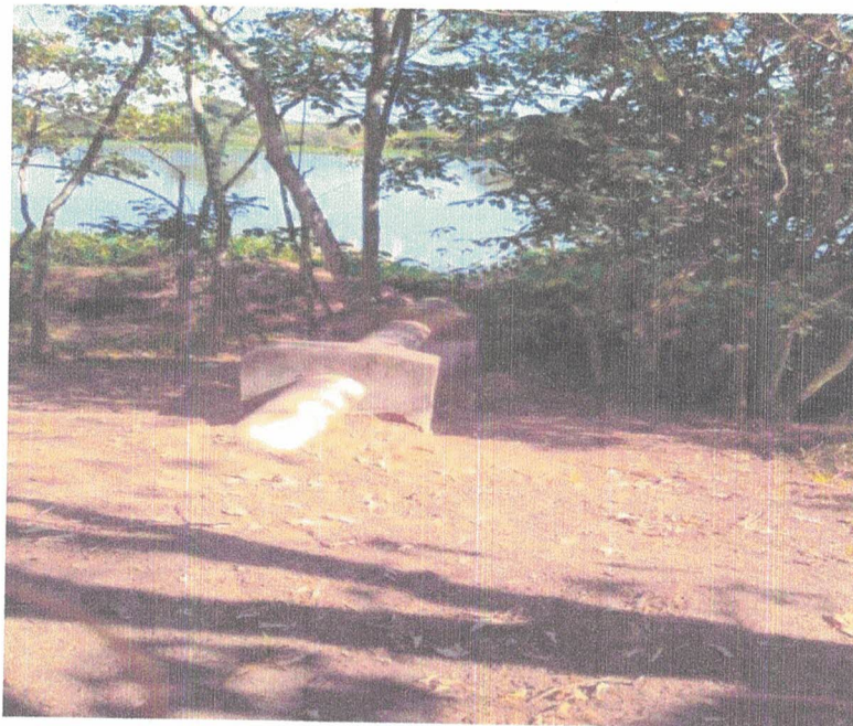
Figura 44 – Saída do Esgoto Tratado
